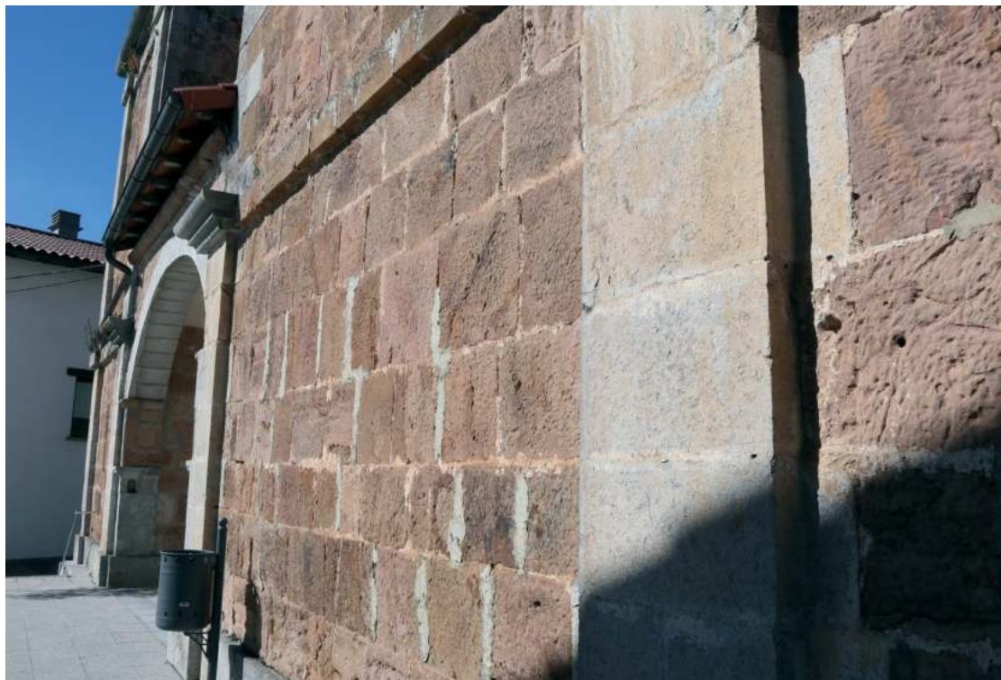
En la fachada de la iglesia de San Tiburcio en Oroquieta se aprecian aún hoy en día varios impactos de bala recibidos durante el enfrentamiento.
